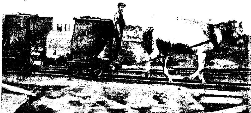
Фиг. 3. Перевозка грязи в вагонетках конной тягой.
