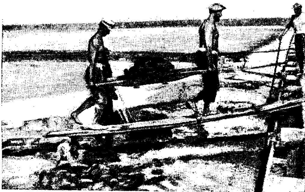
Фиг. 4. Выборка грязи из бассейна и переноска на эстакаду.
